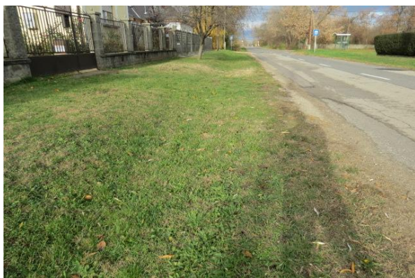
Dinnyési út csapadékvíz elvezető árok
