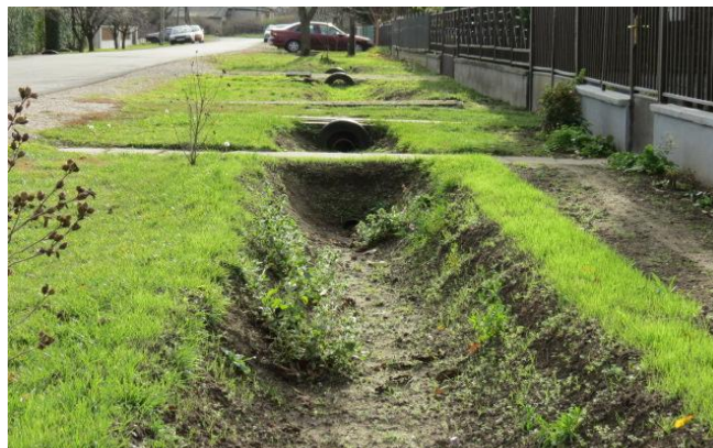
Példa a Gárdonyi Géza utcában (Úttörő utca) a csapadékvíz elvezető árok megfelelő állapotára
